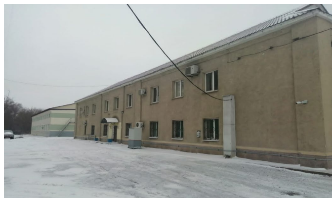
Рисунок 7. Существующее здание поста ЭЦ-1
