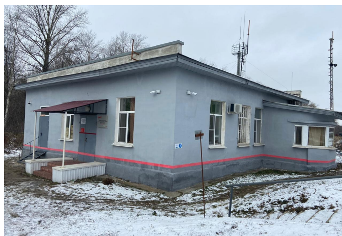
Рисунок 8. Существующее здание поста ЭЦ – 2
